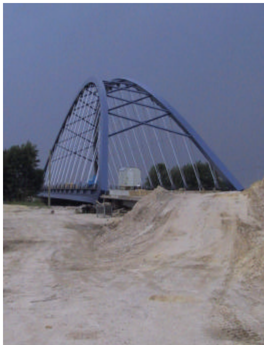
Stabbogenverbundbrücke während der Bauphase
