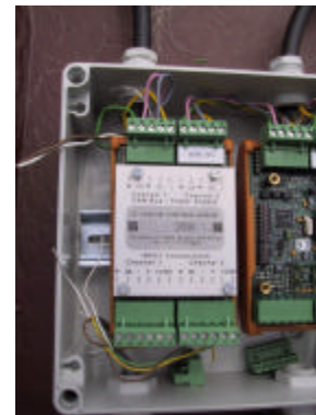
Montage der Verstärkungsmodule
